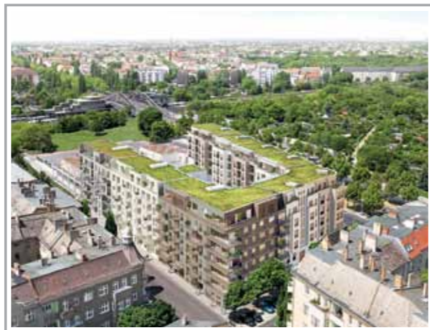
Blick auf das Neubauprojekt nio
