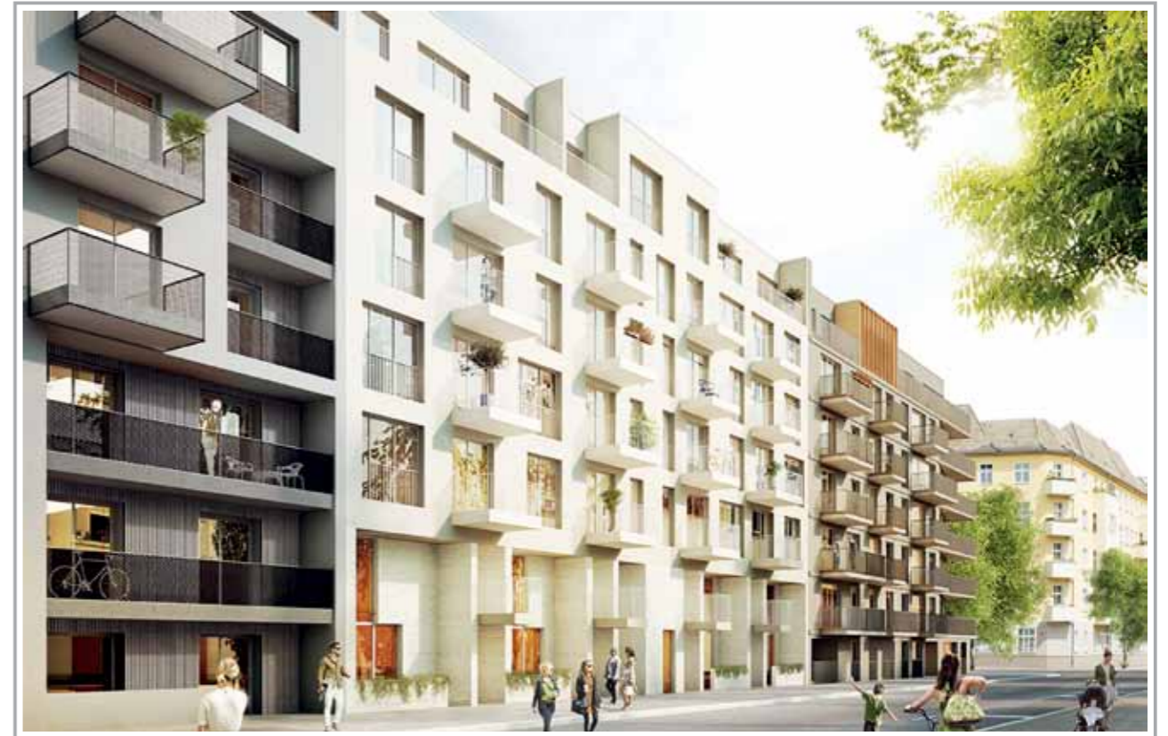
Entlang der Finnländischen Straße entsteht das Neubauprojekt nio
